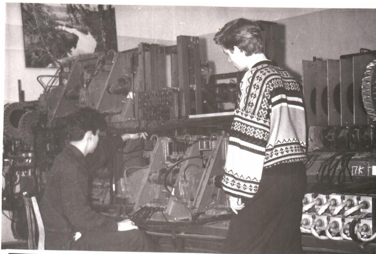
Лаборатория систем управления ЭПС. Стенд по электрическим аппаратам и системе управления электровоза ВЛ11
